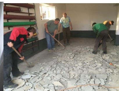
Nová podlaha v pož. zbrojnici
